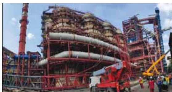
Рис. 7. Внешний вид строящихся воздухонагревателей ДП № 3 ПАО «Северсталь»
