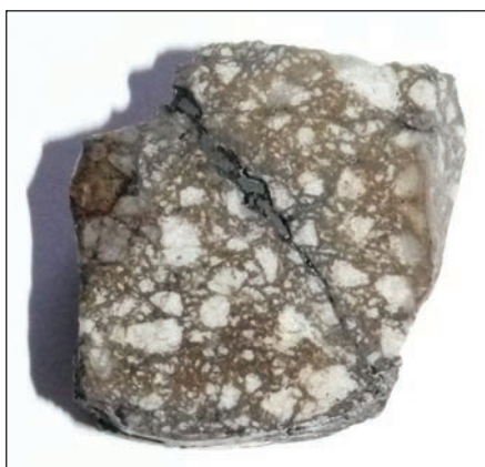
Рис. 2. Трещины в переходной зоне футеровки, заполненные расплавом металла и шлака
