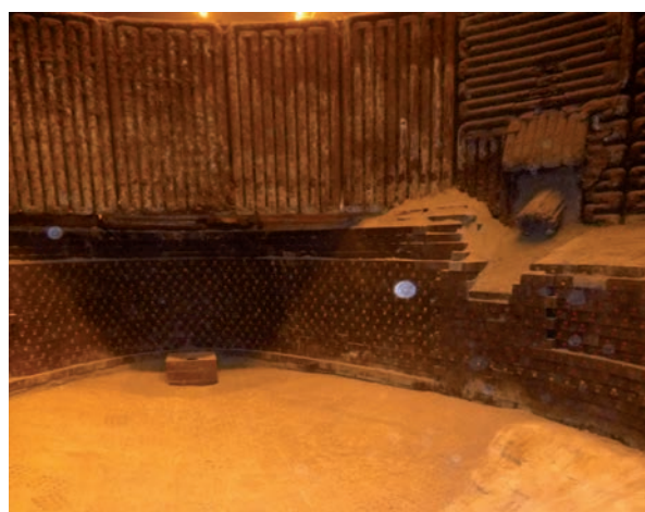
Рис. 2. Футеровка ДСП-150 после монтажа рабочего слоя стен (вид изнутри) и установки водоохлаждаемых панелей
