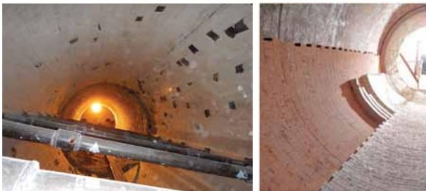
Рис. 6. Футеровка вращающейся печи № 6 для обжига извести ИДЦ
