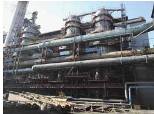
Рис. 2. Внешний вид воздухонагревателей доменной печи № 5 ПАО «Северсталь»
