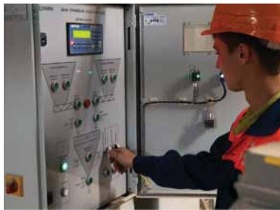
Рис. 5. Пульт управления линией приготовления огнеупорной массы пресса ДАО-242
