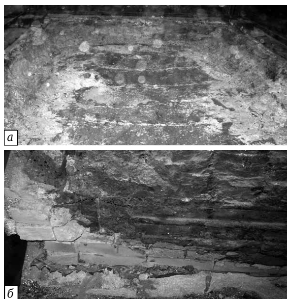
Рис. 1. Состояние поверхности подины, смонтированной из углеграфитовых блоков с 70–80 % графита (а); б — поперечный разрез блока
