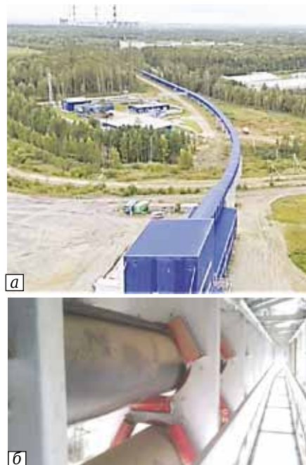
Рис. 1. ТЛК для транспортировки золы Рефтинской ГРЭС: а — общий вид трассы 4390 м; б — грузовая и порожняя ветви свернутой в трубу ленты с цилиндрическими роликоопорами
