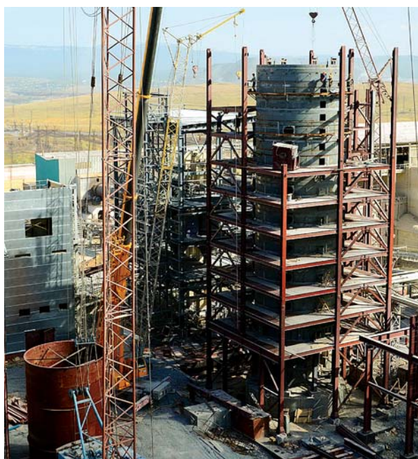
Рис. 6. Строительство многоподовой печи в ОАО «Комбинат «Магнезит» (август 2012 г.)
