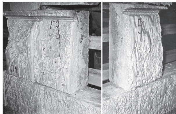
Рис. 1. Брусня бадделеитокорундовых огнеупоров в огнеупорной кладке стекловаренной печи, остановленной на ремонт
