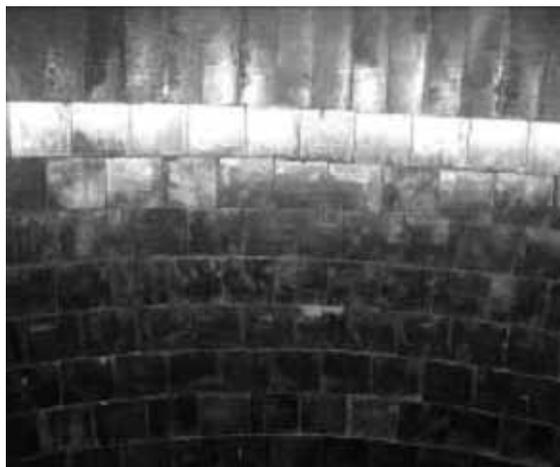
Рис. 5. Нижняя часть вакуум-камеры, выполненная из безобжиговых периклазошпинельных изделий
