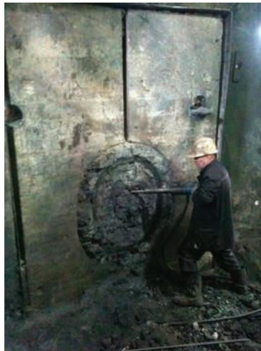
Рис. 6. Подготовка к отбору пробы из леточного канала внутри доменной печи № 4 во время капитального ремонта
