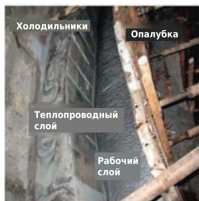
Рис. 5. Безуглеродистая наливная комбинированная футеровка стен горна из бетонов марки Metrapump
