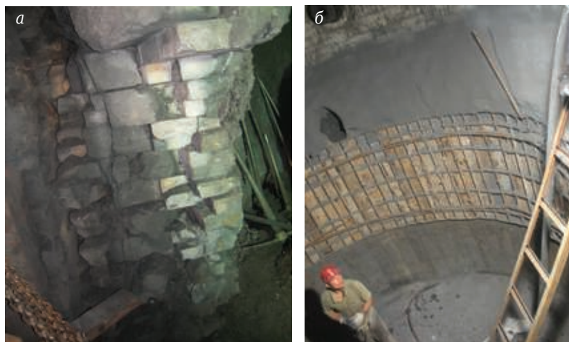
Рис. 3. Поврежденная футеровка стен горна до восстановления бетоном марки Metpump (а) и футеровка горна после заливки бетоном марки Metpump с верхней частью опалубки, оставленной на задувку, и с зашоткретированным стыком стен горна и дна лещади (б)
