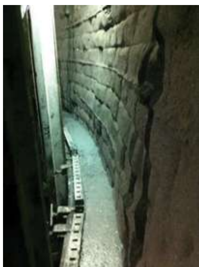
Рис. 12. Закачка раствора на золь-гель связке между опалубкой и остаточной углеродистой футеровкой хорошего качества для восстановления изношенной футеровки стен горна
