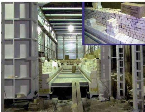
**Рис. 5.** Футеровка высокотемпературной печи ОАО «Речицкий фарфоровый завод»
