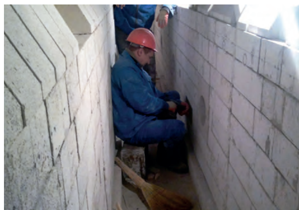
Рис. 3. Монтаж огнеупоров НК-30 в футеровке водородной печи ОАО «Электросталь»
