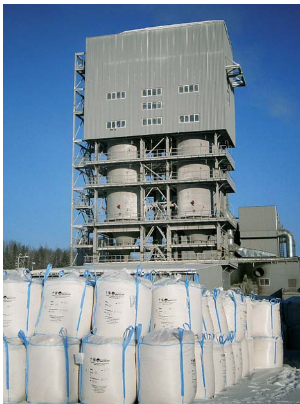
Рис. 5. Шахтные печи каустизации магнезита
