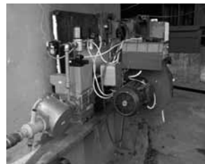
Рис. 2. Установка временных горелочных устройств
