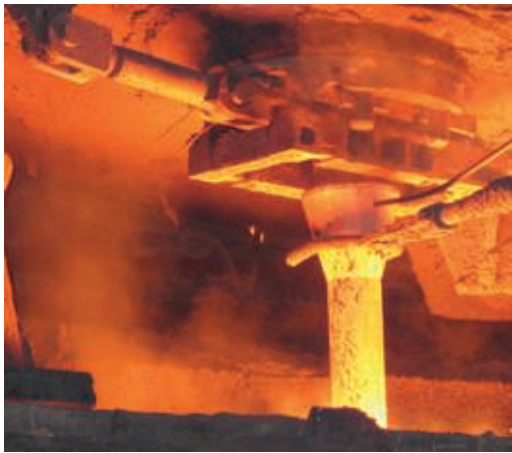
Рис. 9. Кварцевая защитная труба в эксплуатации на ММК
