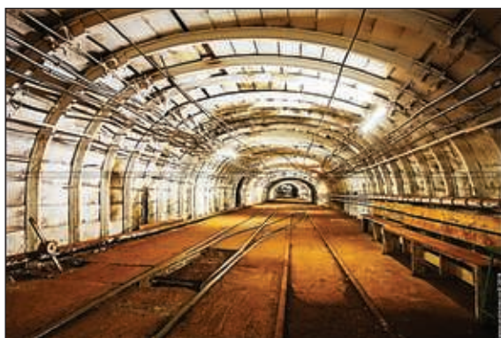
Рис. 1. Стяжная анкерная крепь арочной выработки шахты Ново-Кальинская ( https://uralmines.ru/subshahta-novo-kalinskaya/ )
