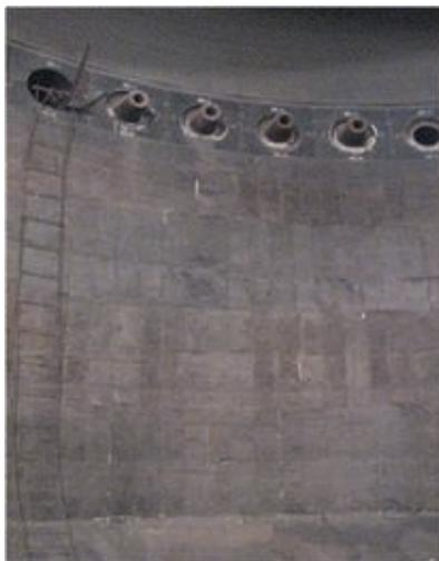
Рис. 1. Искусственный гарнисаж футеровки горна ДП объемом 5500 м<sup>3</sup>, выполненный из бетона марки Metpump
