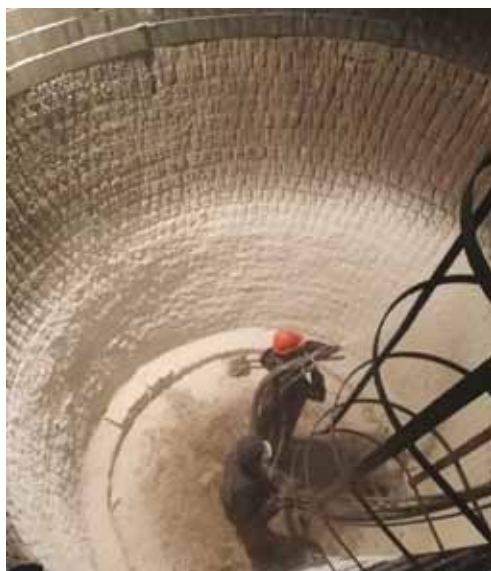
Рис. 1. Процесс нанесения шоткрет-слоя на поверхность сталеразливочного ковша
