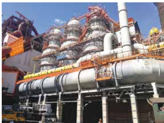
Рис. 9. Внешний вид воздушонагревателей ДП № 6 АО ЕВРАЗ НТМК
