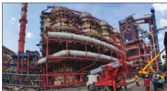
Рис. 7. Внешний вид строящихся воздухонагревателей ДП № 3 ПАО «Северсталь»
