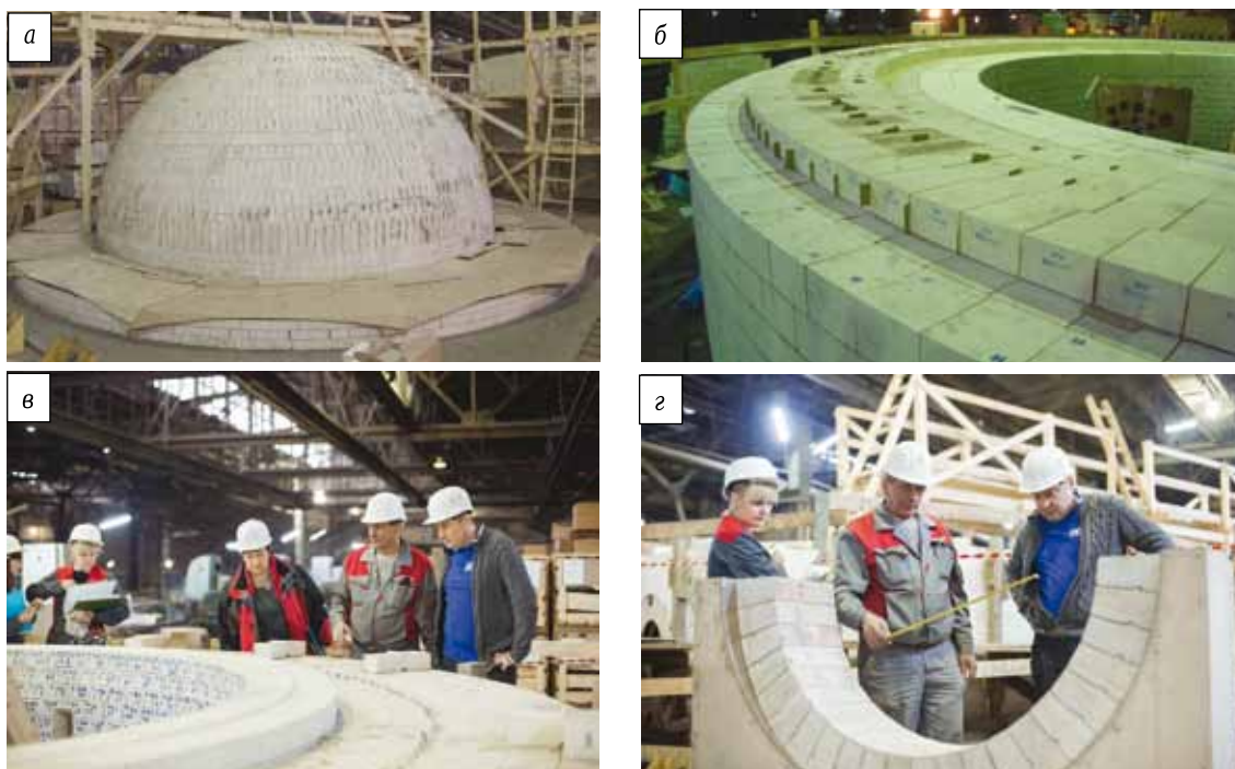
Рис. 5. Стендовая сборка и приемка продукции в АО БКО в присутствии представителя АО «КАЛУГИН»: а — купол ВНК; б — воздушный коллектор; в — газовый коллектор; г — арка штуцера горячего дутья
