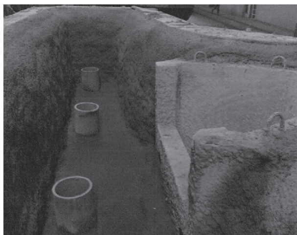
Рис. 6. Установка оборудования разливочного отверстия в ПК сортовой МНЛЗ
