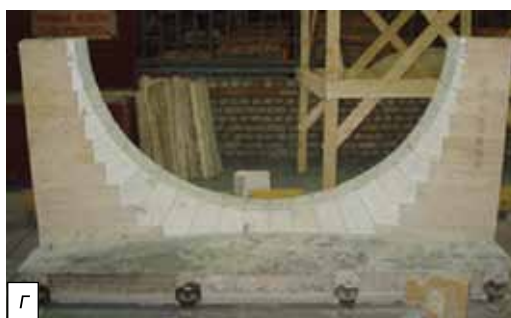
Рис. 3. Процесс стендовой сборки элементов воздухонагревателя: а, б — сборка купола воздухонагревателя; в — собранный купол; г — собранная арка штуцера
