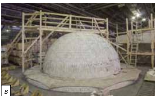
Рис. 3. Процесс стендовой сборки элементов воздухонагревателя: а, б — сборка купола воздухонагревателя; в — собранный купол; г — собранная арка штуцера
