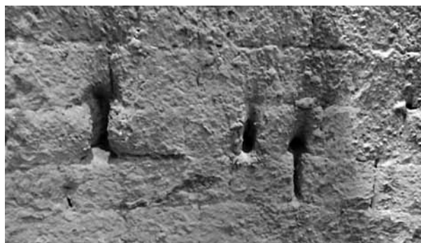
Рис. 3. Проявление локального износа вследствие механических и термических напряжений
